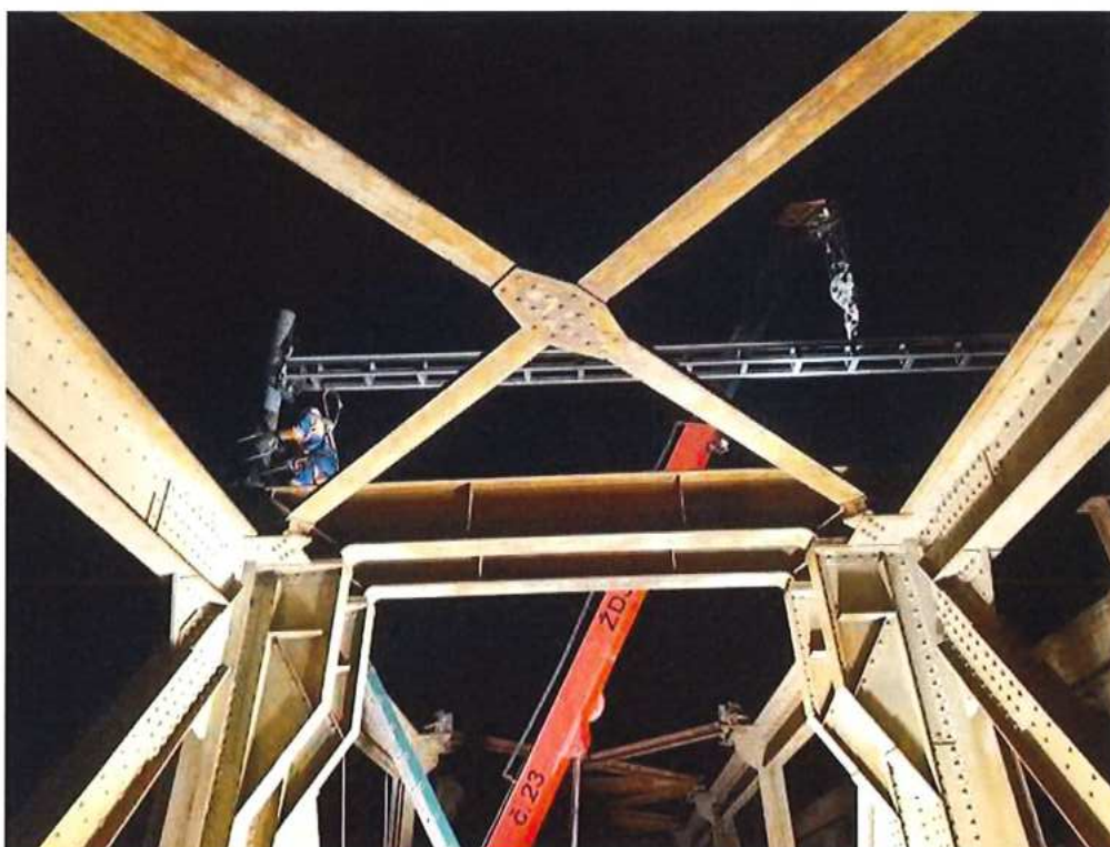
Demontáž brány trakčného vedenia
